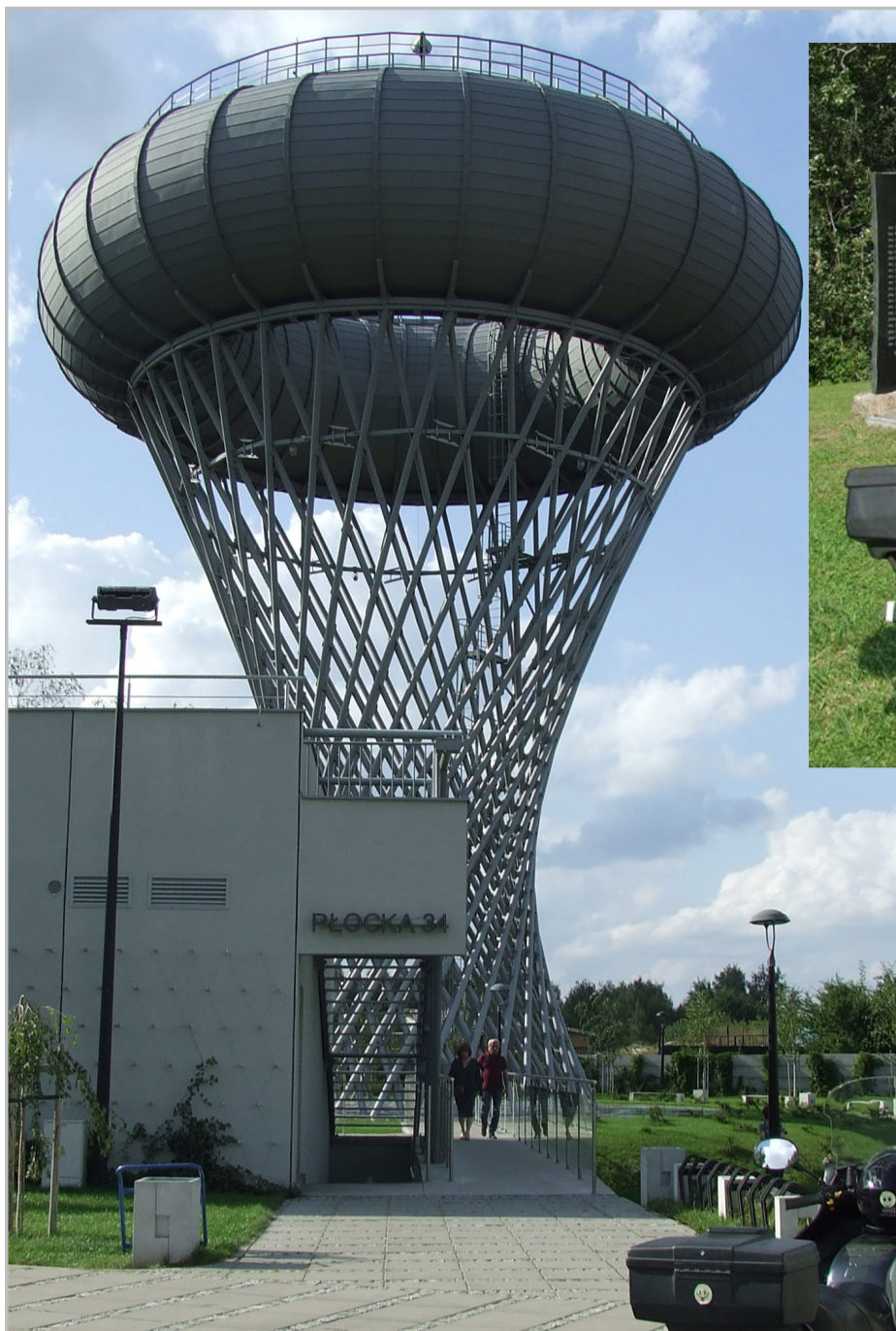
Niezwykle modernistyczna dawna wieża ciśnię. Ten obiekt teraz mieści „Park Nauki Torus”.
