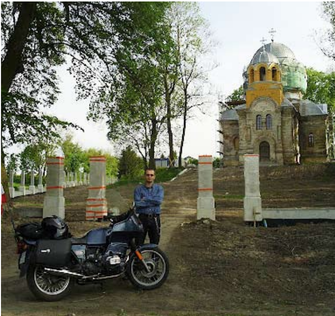
Dołhobyczów. Cerkiew w trakcie renowacji
