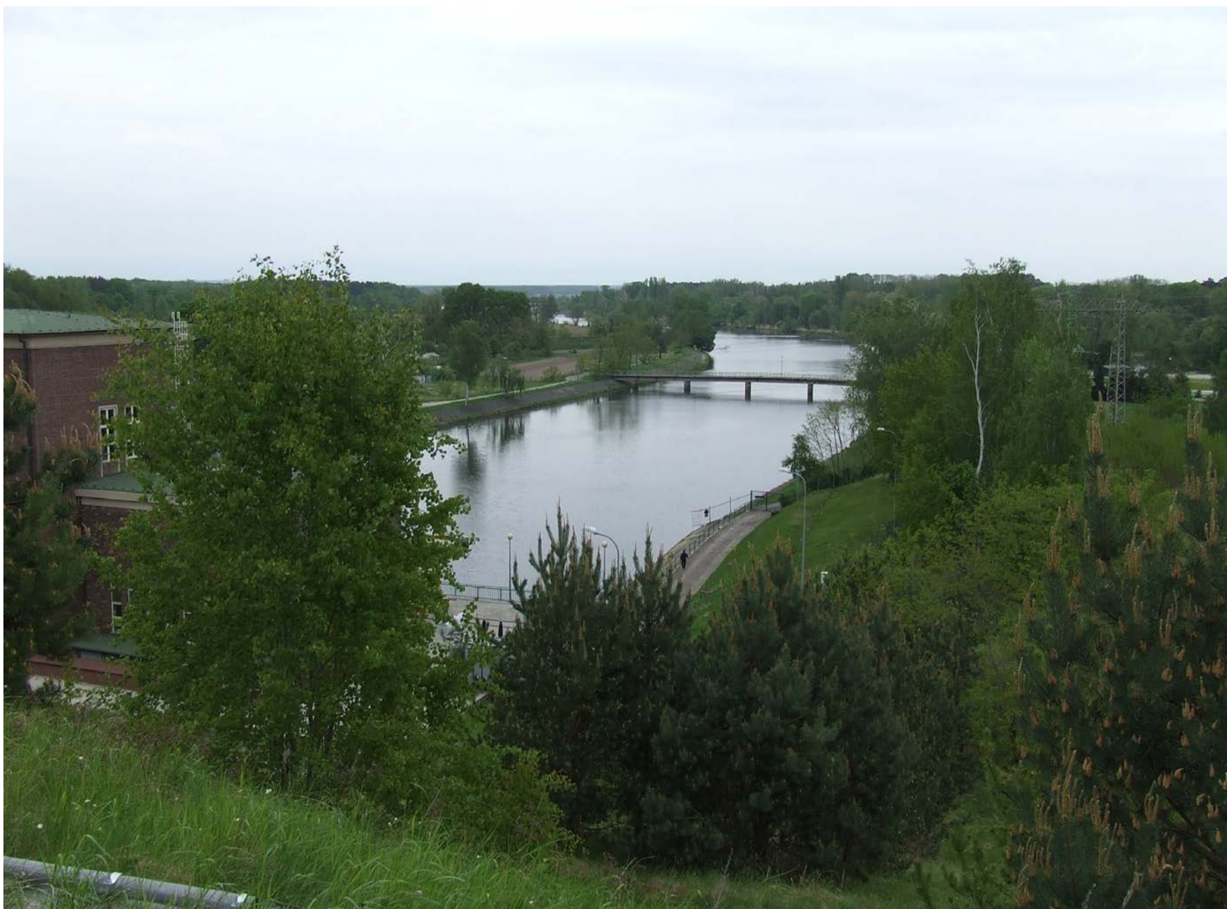
Dychów. W pobliżu elektrowni wodnej na Bobrze.
