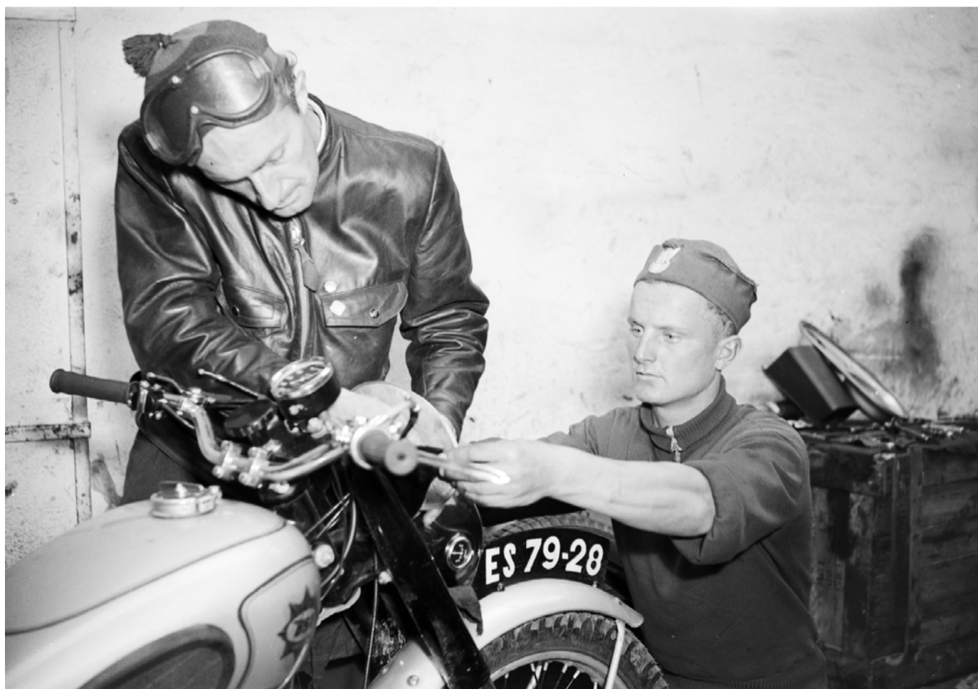
Sportowy motocykl BSA Gold Star podczas naprawy w warsztacie wojskowym.
